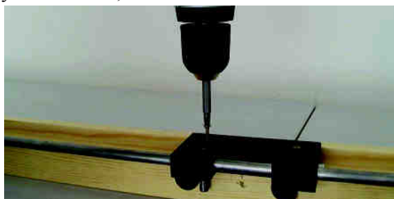
Rys.6. Przykręcanie korpusu wkrętami.
